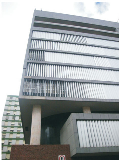
Fig. 2.25: Brise-soleil na fachada do Tribunal da Justiça de Porto Alegre. Fonte: acervo PET
