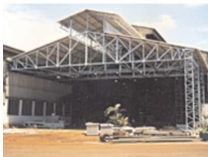
Fig. 2.36: Galpão com lanternim.
