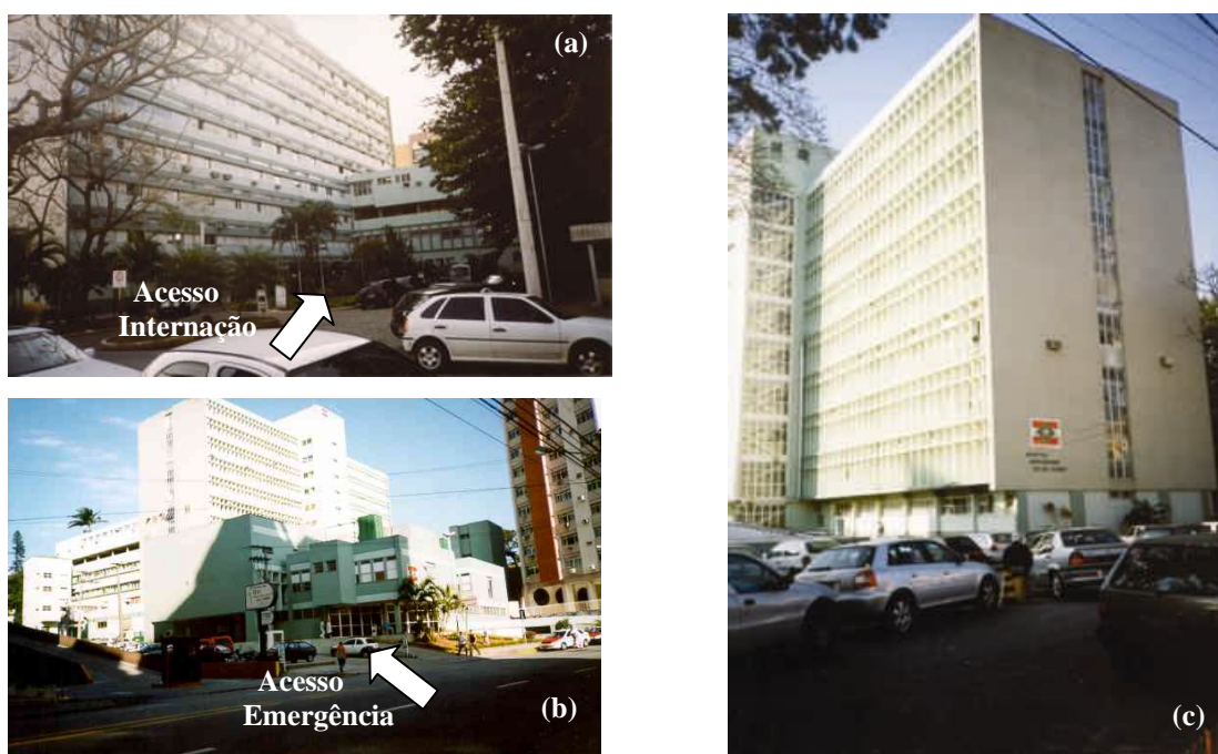
Figura 5.8: Hospital Governador Celso Ramos (a) torre principal; (b) bloco ampliado com torre ao fundo, e acesso da Emergência;(c) torre principal com volume da escada.
