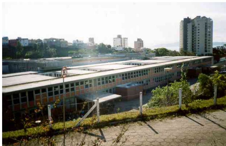
Figura 5.2: Vista geral do Hospital Infantil Joana de Gusmão.
