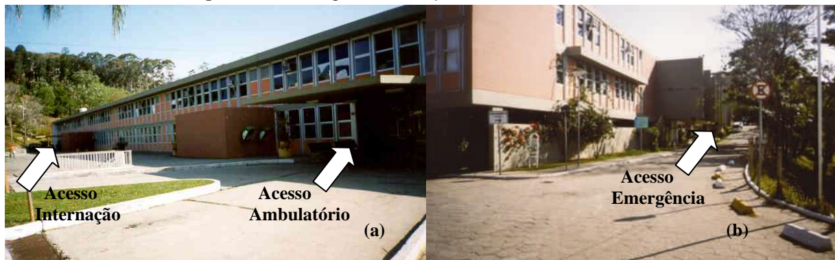
Figura 5.3: (a) Fachada frontal com acessos para o Ambulatório e para a Internação (pacientes e visitantes); (b) fachada lateral direita com acesso à Emergência.
