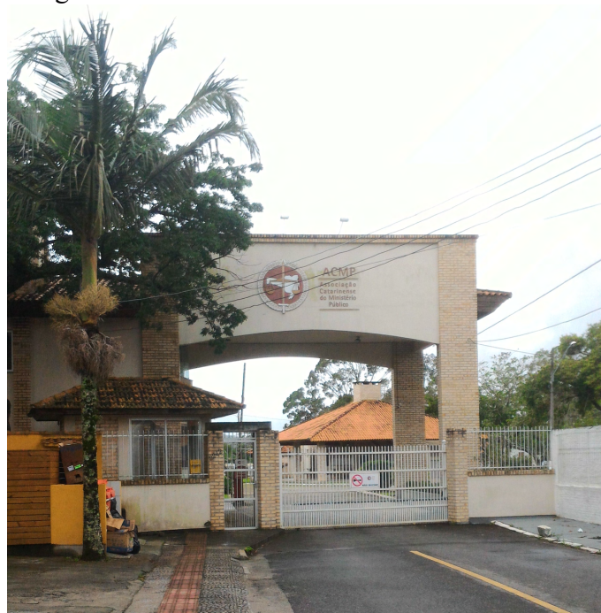
Figura 1 — Fachada da sede balneária da ACMP
