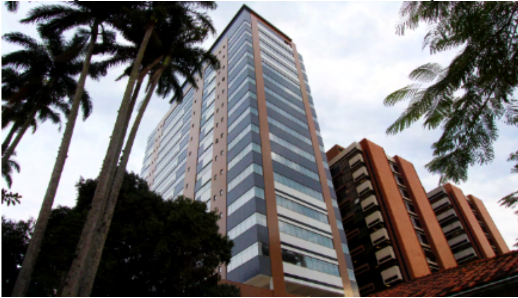
Figura 2 — Prédio da Procuradoria do MPSC em Florianópolis
